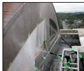
外壁廻り散水状況
