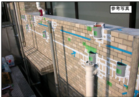
静水圧調査液注入試験調査状況写真
