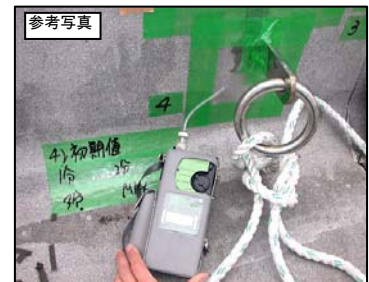
参考写真 屋上防水層検知状況
